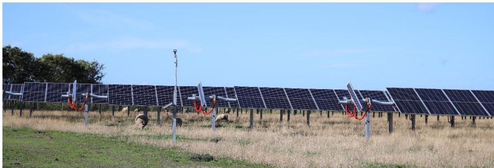
Figur 2.3: Solceller på trackerstativer med vindmåler.
